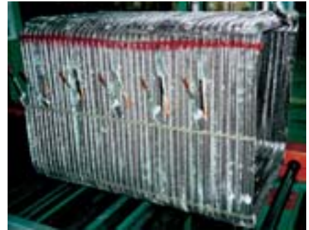
Este serpentín de bomba de calor de Trane, de alta eficiencia y de circuito múltiple, solamente tiene uniones a las entradas y salidas de los circuitos. Este serpentín en particular requiere de 10 conexiones soldadas. Un serpentín de enfriamiento similar tiene incluso menos uniones.
