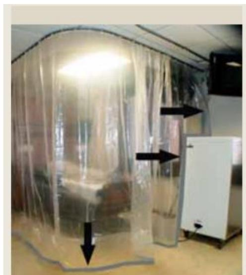
Figura 7. Cortinas de aire hasta el piso y equipo HEPA
