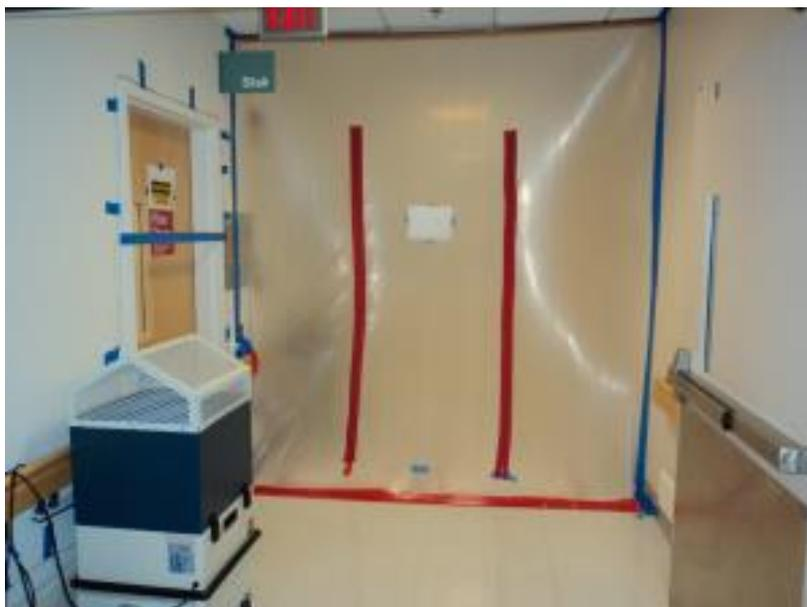
Figura 12. Ejemplo de crear una barrera de presión
